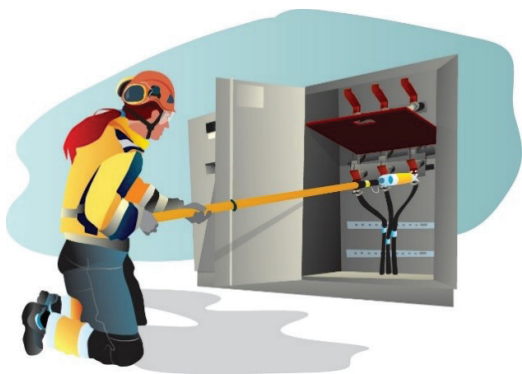
Bild 1. Avskärmning med isolerskiva (isolerad säkerhetsanordning).
