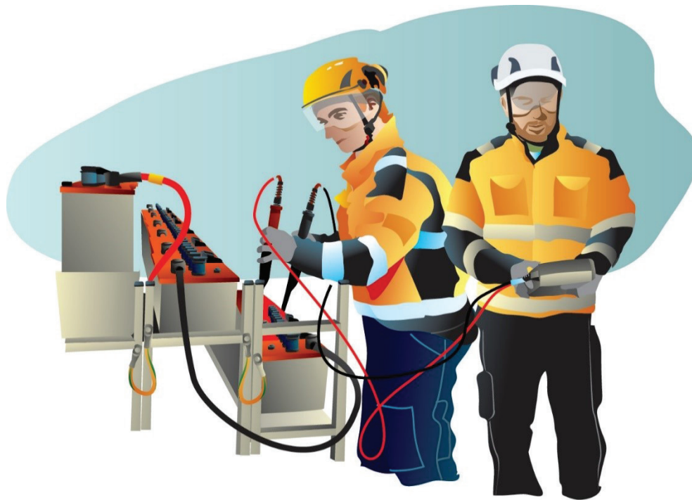
Bild 11. Spänningsprovning av batterianläggning.
