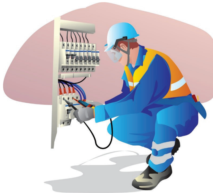
Bild 3. Spänningsmätning i lågspänningsanläggning.
