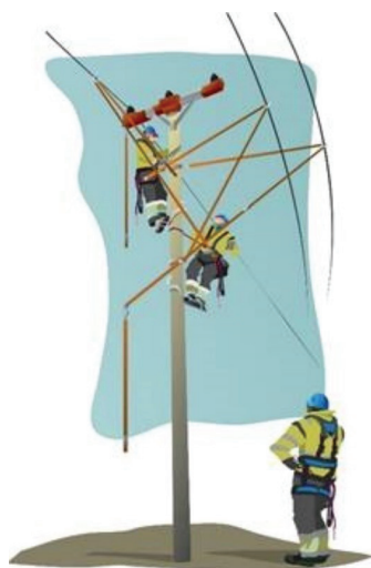
Bild 35. Säkerhetsman vid Arbete med spänning.
