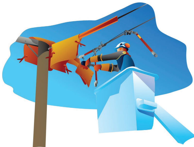
Bild 36. Arbete med isolerhandskmetoden enligt arbetsmetoden Arbete med spänning.
